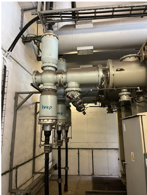
Foto 5 – rozvětvení kabelového vedení u T115
