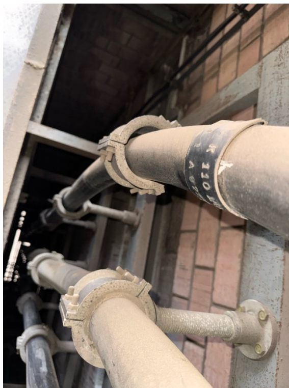
Foto 4 - chybějící gumové vložky svorek
