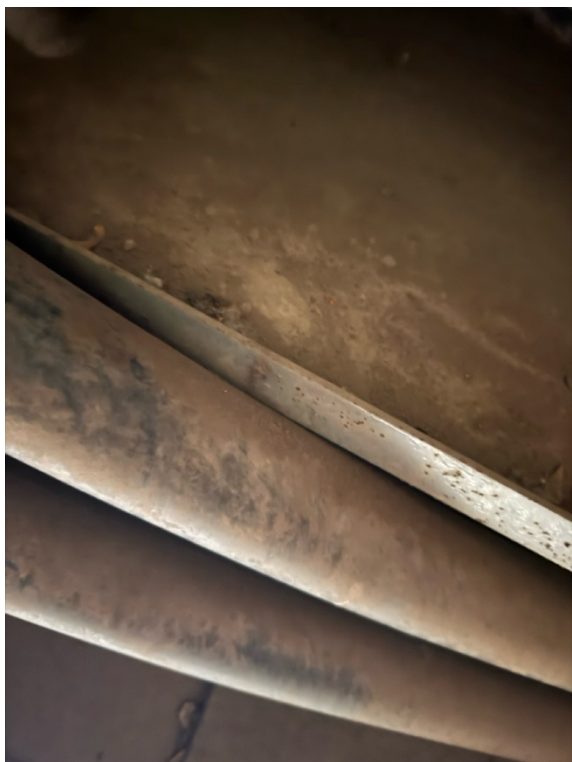
Foto 3 - nevhodné umístění kabelů na lávce
