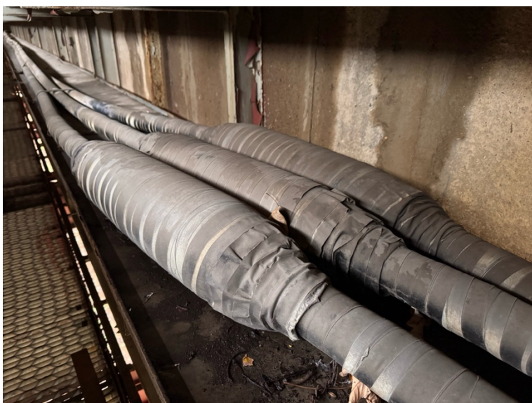
Foto 2- nevhodné umístění spojek
